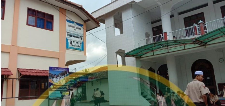
Gambar 4: Wilayah Masjid Jami' MWI Kebarongan
