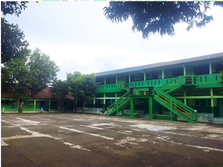
GAMBAR 1.4: Gedung MTs. Nurul Islam Randudongkal
