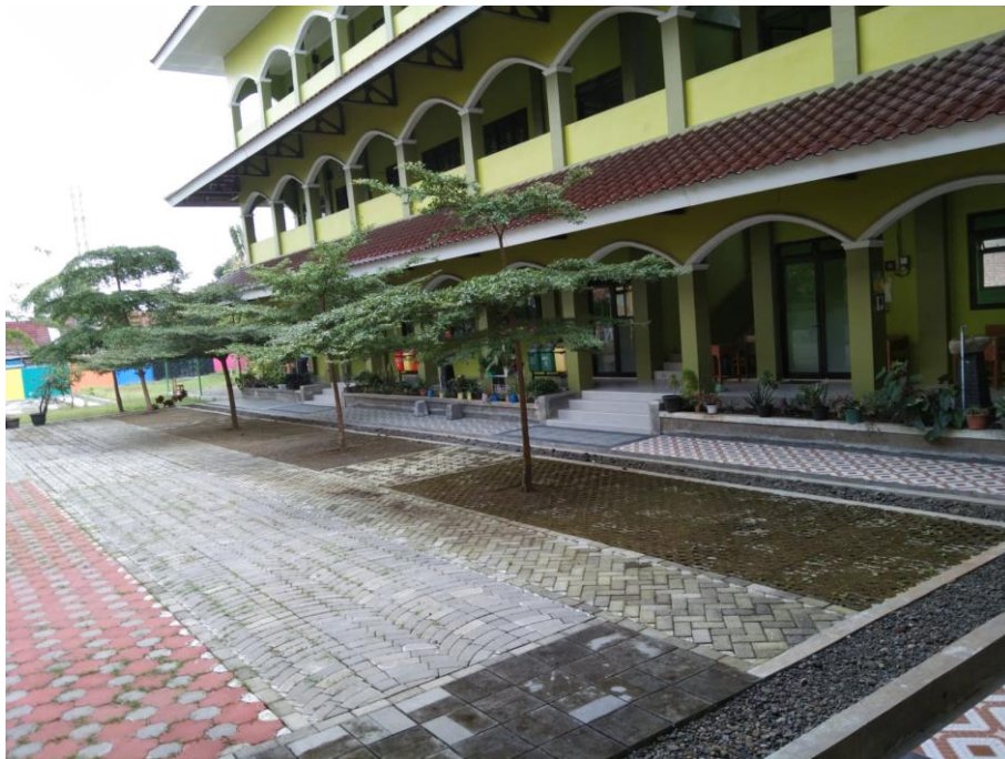
Ruang Kelas Sebelah Utara Gedung Kedua (Kampus II) MIN 1 Banyumas
