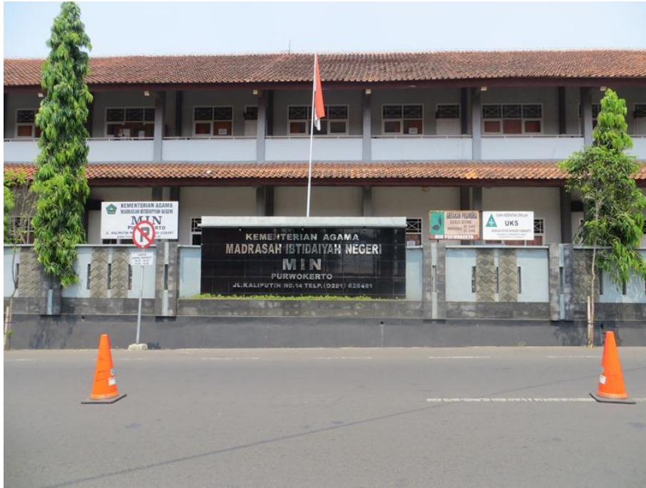
Kondisi Gedung Pertama (Kampus 1) MIN 1 Banyumas
