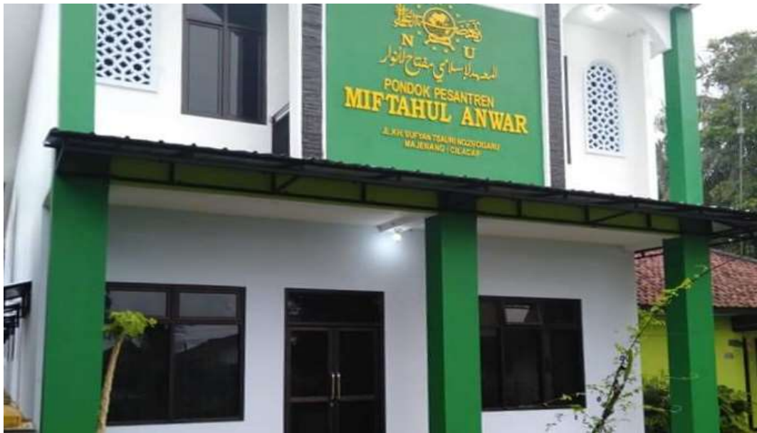
Gedung Asrama Putri Tampak Depan
