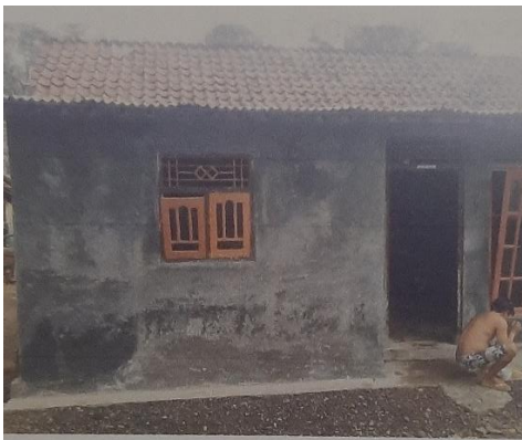
Gambar 14 Foto rumah setelah direhab
