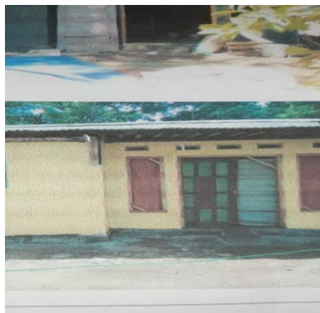
Gambar 12 Foto rumah setelah direhab
