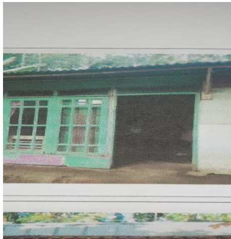
Gambar 11 Foto rumah sebelum direhab
