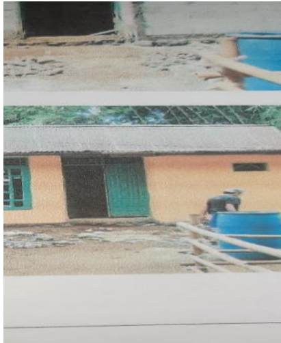
Gambar 10 Foto rumah setelah direhab
