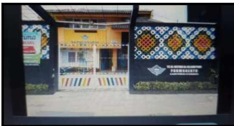
Gedung TK Al Irsyad Al Islamiyyah Purwokerto
