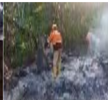
Gambar 23 : Aksi Cepat Tanggap pembersihan puing bangunan sisa kebakaran rumah.
