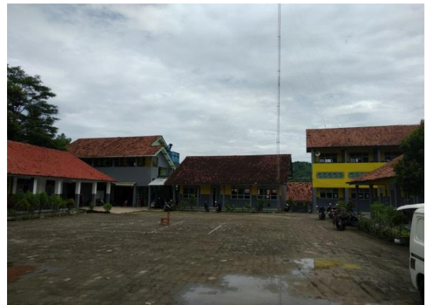
GEDUNG SMK AL FURQON BANTARKAWUNG
