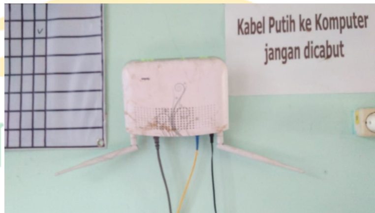
Gambar 19. Perangkat Router Wifi di Ruang Guru
